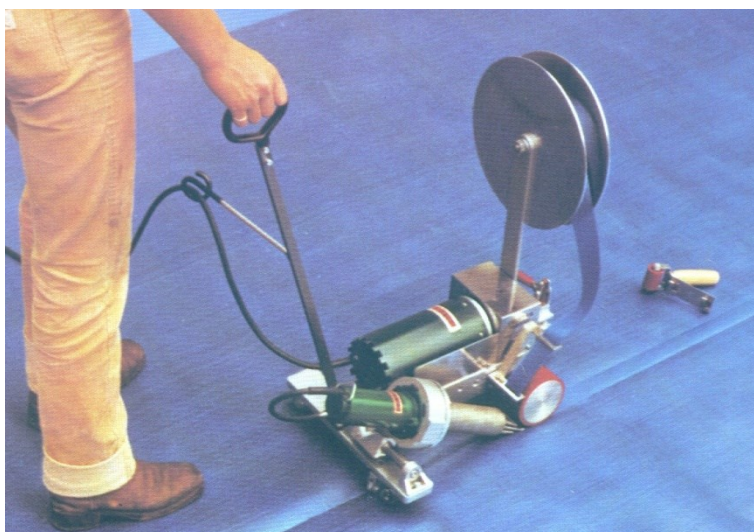
Rysunek 11. Zgrzewanie gorącym powietrzem polietylenowej wykładziny basenu pływackiego taśmą o szerokości 2cm.
